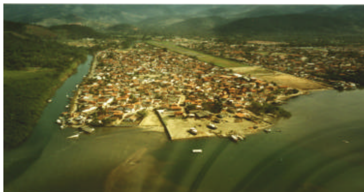
Figura 22: Foto aérea dos bairros da Ilha das Cobras e Mangueira. À esquerda o rio Mateus Nunes e à direita a pista do aeroporto de Paraty.
